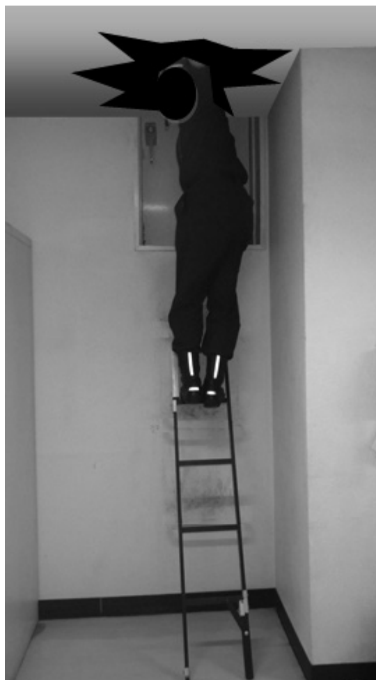
⑪梯子に変え、天井裏を確認する
