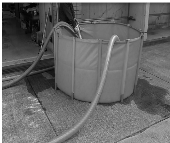
(図4-1) 吸管1本吸水で放水中、エゼクタ操作により2本目の吸管(手前側の透明吸管)から吸水
