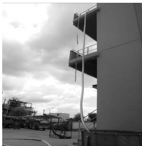
( 図 3 - 1 ) 高落差のある吸水 落差は約9メートル
