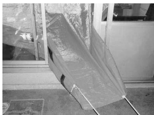
開口部（排水箇所）の様子。 シートの端をロープ等で張る。
