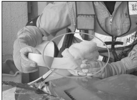
切断面に当て布を巻き付けテープで固定
