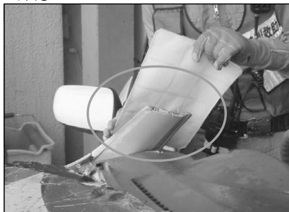
切断面に多目的安全シートの貼り付け
