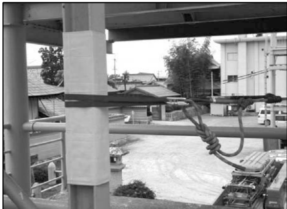
支持物に多目的安全シートの貼り付け
