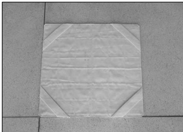
原因物質の上に多目的安全シートの貼り付け
