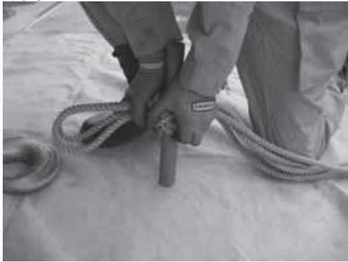
木製トグルは、地面に打ち付けて抜いていた
