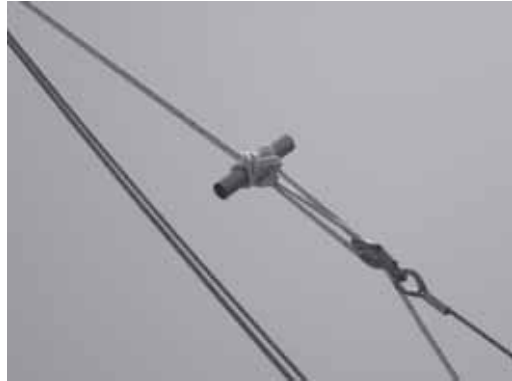
ちょう結びに従来金属性トグルを差し、ウインチで展張している状況
