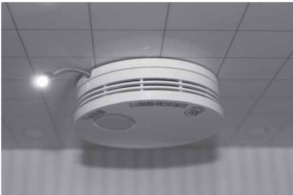
写真2 避難口照射灯「光らナイト」作動状況写真
