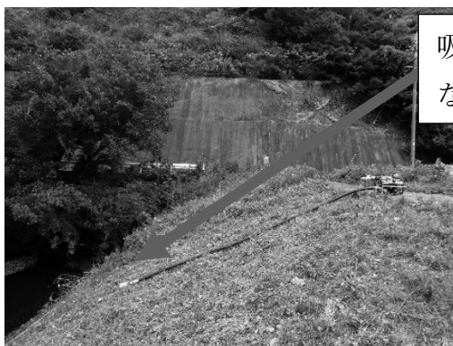
既存の可搬式ポンプを使用し、池で水利部署した様子
