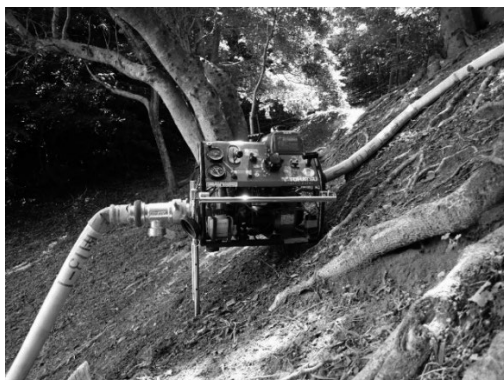
可搬式ポンプ水平装置を山の斜面で使用した様子
