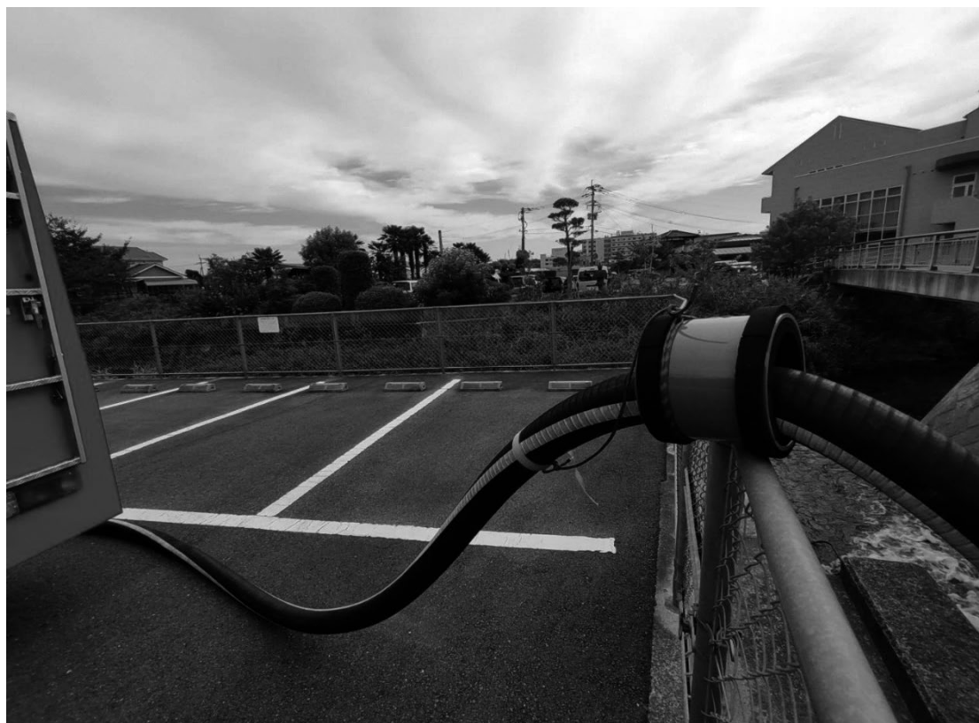
写真8 吸水時の吸管備え付け型枕木の状況
