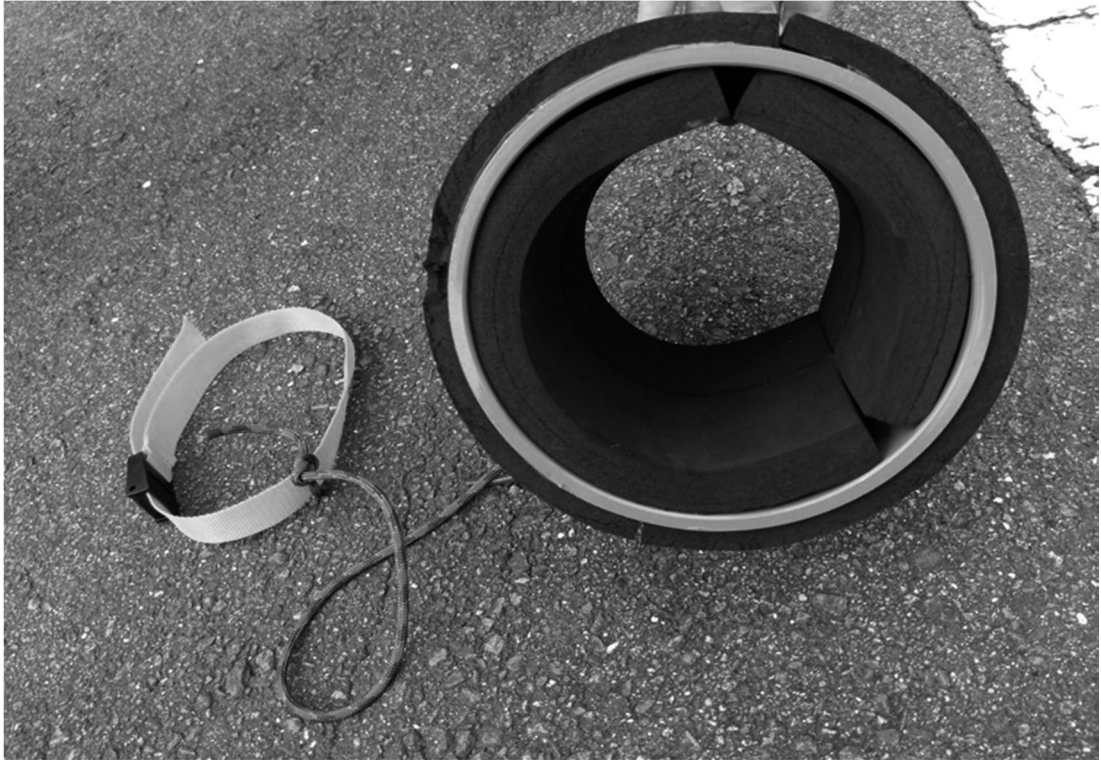
写真1 塩ビ管に耐震ゴムを取付けた状況
