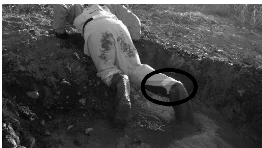
(写真5) 土圧により長靴内部で足が抜け 自力では脱出困難な状態。
