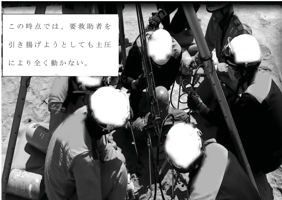
写真7 空気噴射管を要救助者付近に差し込んだ状態
