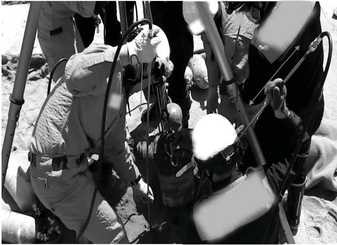
写真8 空気噴射管を上下に動かし、砂内の空洞を拡大
