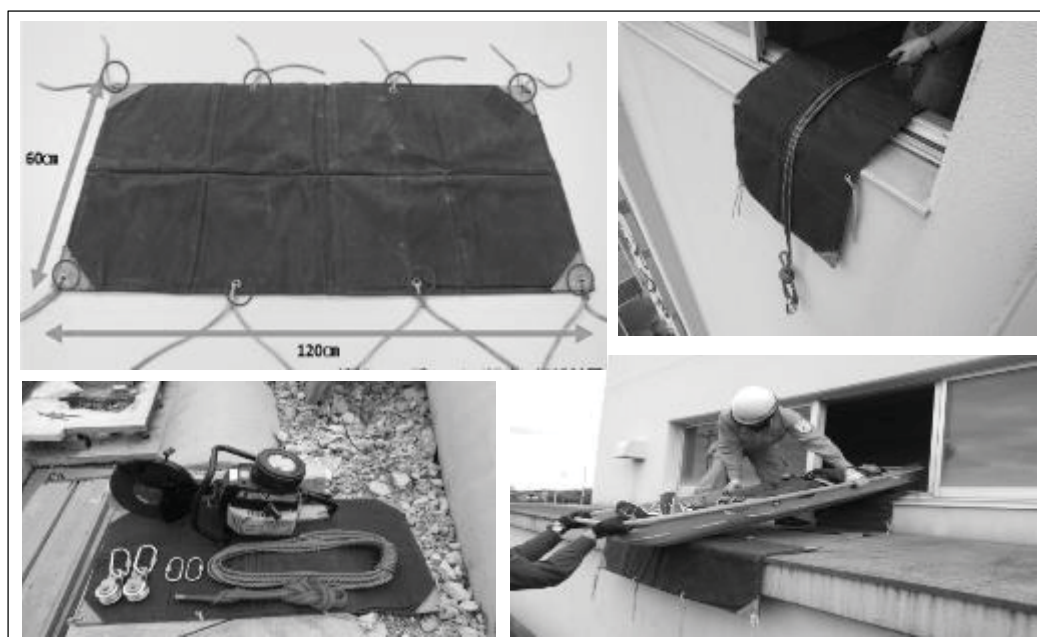
【写真1】当本部で使用している帆布製保護シート(ショックパッド)
