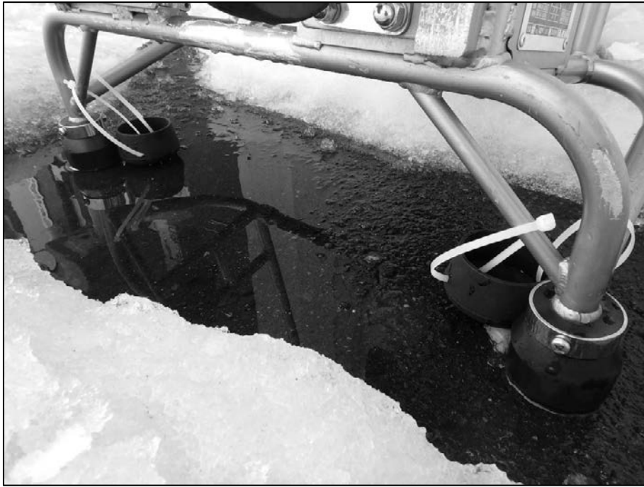
写真N o . 1 1 路面露出時の基底部の状況
