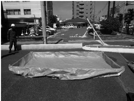
写真 1 3 . 応急除染形態
