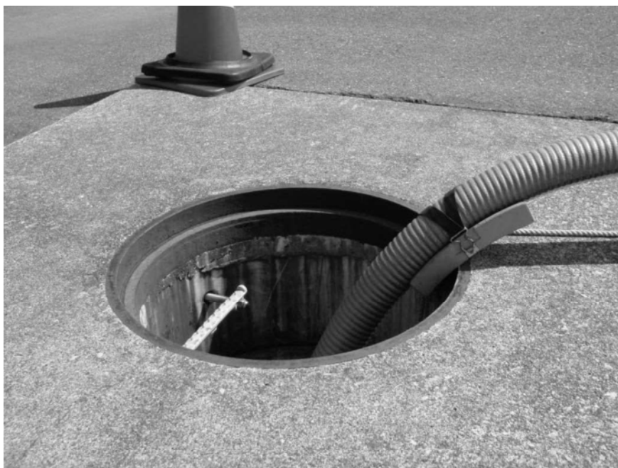
従来品揚水前の状況
