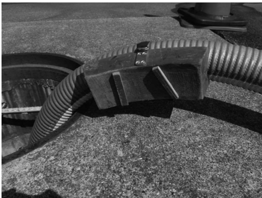
凸部分可動状況 2（写真 7 から吸管をマンホールから引上げた状況）
