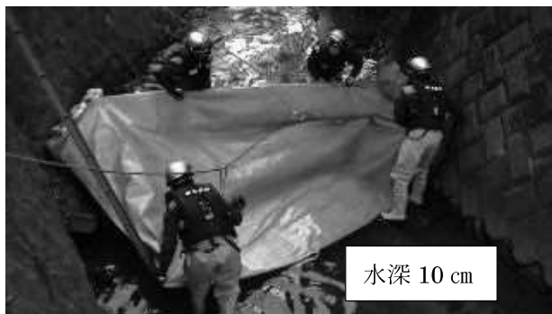
写真3 ブルーシートを約2m引き出し川に沈めます。この時、川の流れに対して水压を逃がすように少し斜めに設定します。
