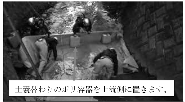
写真4 ブルーシートを川底に対してL字になるように川底に張り付け、両端の余ったブルーシートを上流に向かって折り、横さんの高さまで水位を上げます。
