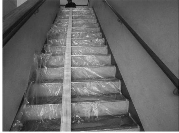
(写真9) 階段の被覆
