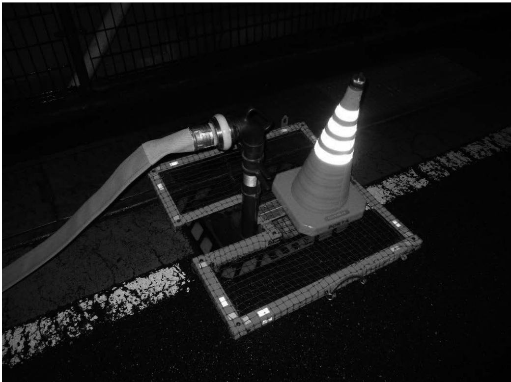
写真No.⑥ 夜間に消火栓へ設置
