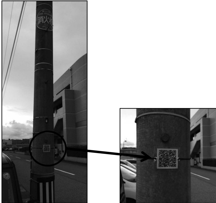
119Rコード 電柱への設置状況
