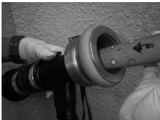
【写真 9】 A B 管そう内への カートリッジ装填状況①
