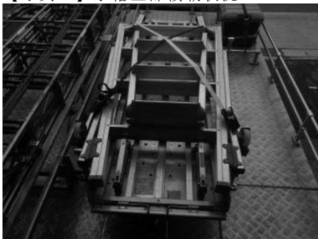
【写真1】 水槽上部積載状況
