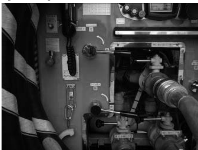
【写真3】 水槽内混合作業
