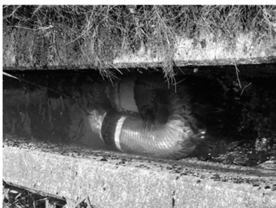
せき止め完了（同時に外筒内へ充水）
