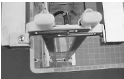
6 カーテンレール取付状況
