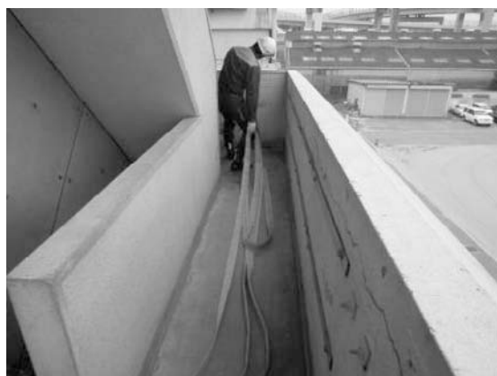
2 3 歩程度進むだけで延長完了
