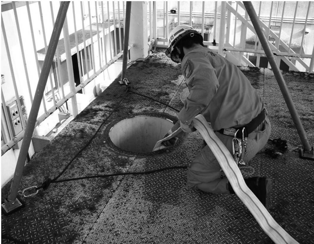
写真⑧ 立て抗内へのエア－送入状況（状況により隊員は呼吸器を着装）
