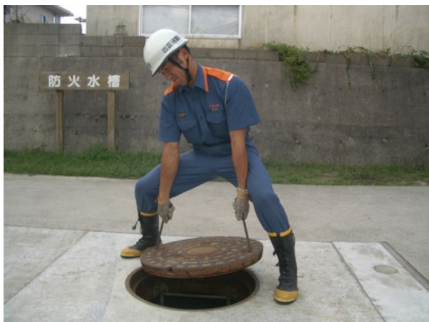
写真3 従来の蓋を開放し吸管を投入した状態。転落・転倒の危険大。
