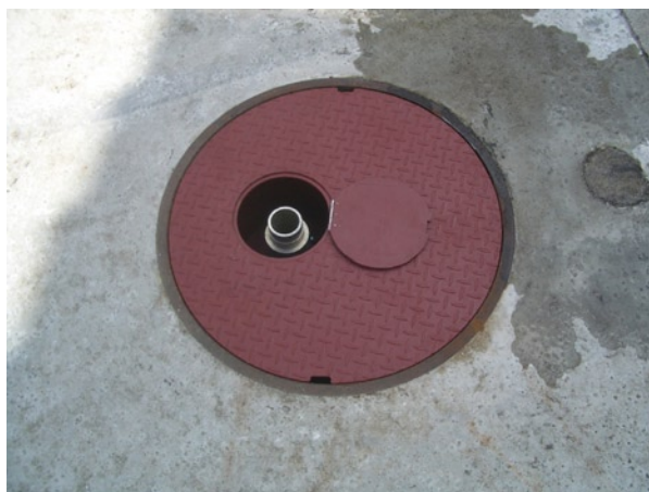
写真6 小蓋を開放すると、結合金具（オス金具）が視認できる。
