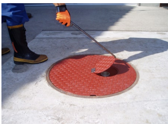
写真5 小蓋は消火栓用手かぎで容易に開放できる。
