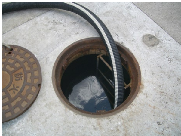
写真5 小蓋は消火栓用手かぎで容易に開放できる。
