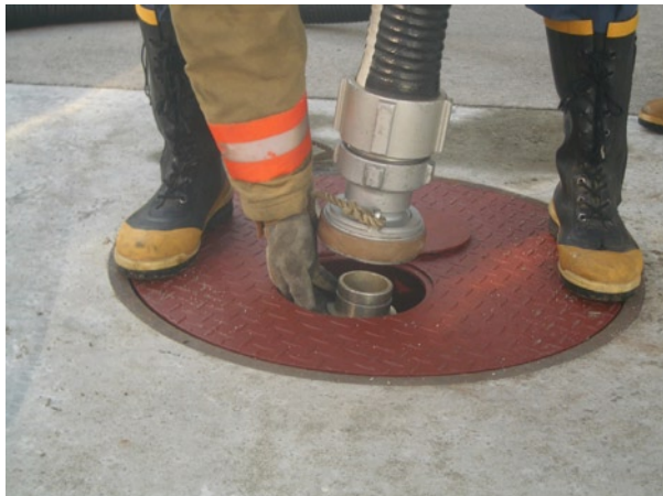
写真7 結合金具がマチノ式のため容易な脱着が可能。
