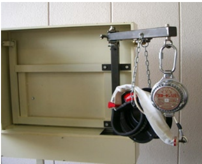
写真5 取り付け金具自動旋回
