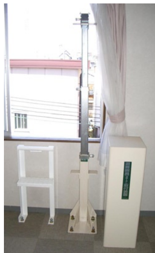
写真5 金具を全伸長する
