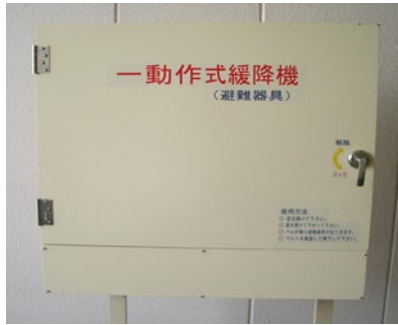
写真1 ボックス収納設置状況
