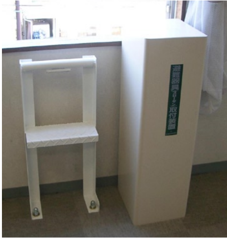
写真3 緩降機を収納ボックスから出す
