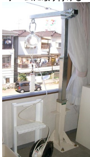
写真6 緩降機をアームに取り付ける
