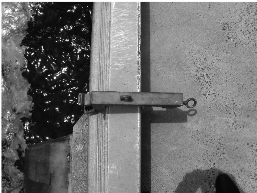
写真 2-2 屋外アンテナ取付用金物上景
